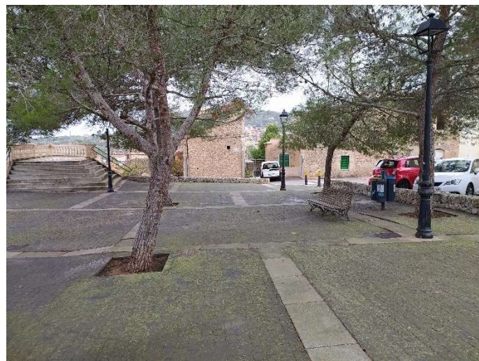
Problemas pavimento actual
